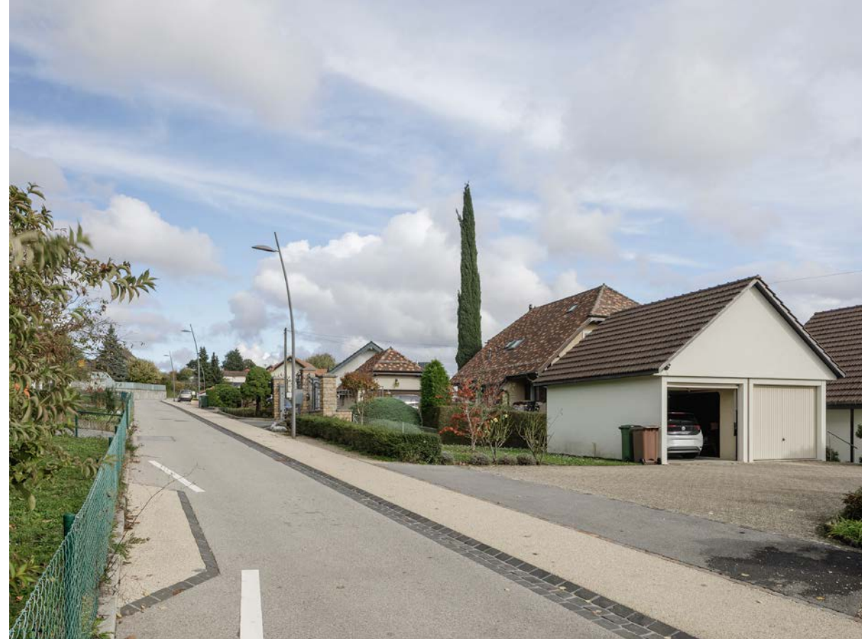
Les rues d'accès ont besoin d'être restructurées et le trafic apaisé. Des traitements de sol différenciés y contribuent. Sans faire le choix de la perméabilité, le confort climatique de la rue n'est pas amélioré. → Traitement des surfaces, p. 36 → Rues d'accès, p. 50 → TIM et stationnement, p. 56
